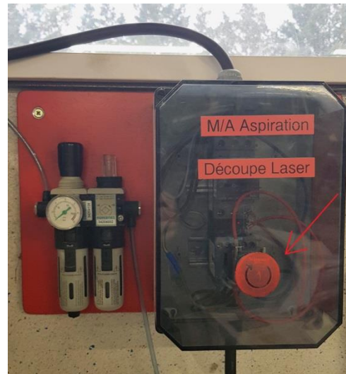
2 – Mettre en route l'aspiration de fumées
